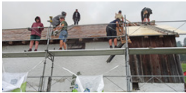
Dachdeckerarbeiten am Gmoawerch
